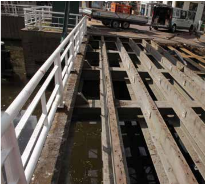
Onderliggende stalen constructie na sloop houten dek.
