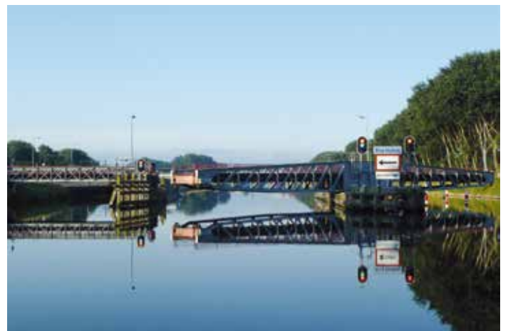
De monumentale draaibrug in Souburg is gerenoveerd met vloeistofdicht InfraCore ® Inside dek.
