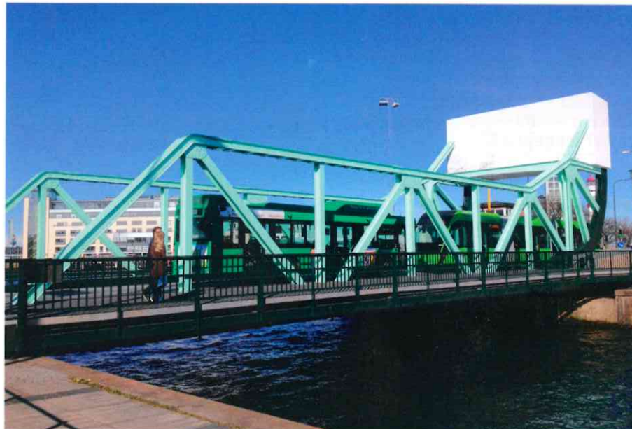
De SUREbridge-technologie blijkt goed toepasbaar voor renovatie van stalen (verkeers)bruggen, zoals deze in het Zweedse Malmö.
