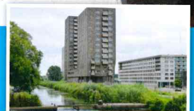
Bouwen in of op de dijk
