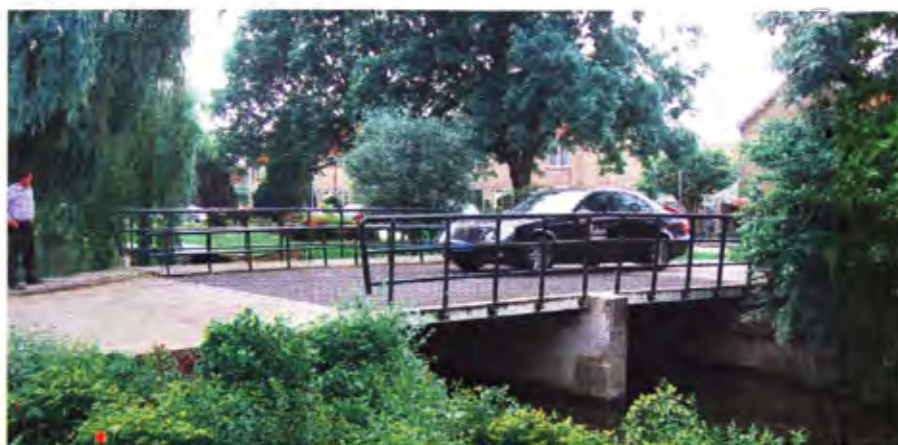
Niemand die het ziet maar ook deze verkeersbrug in Oostzaan heeft een dek van composiet.
