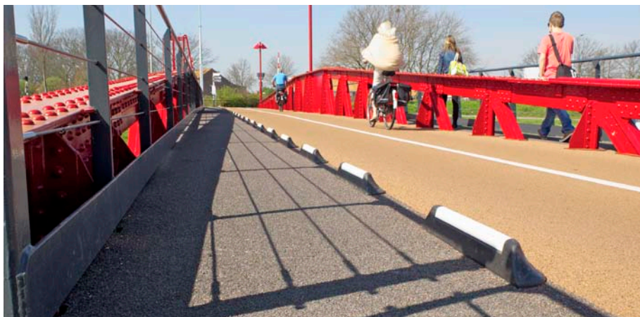
Groot onderhoud aan het staal is pas over ongeveer dertig jaar nodig, terwijl het brugdek zo'n honderd jaar mee kan, zonder serieus onderhoud.
