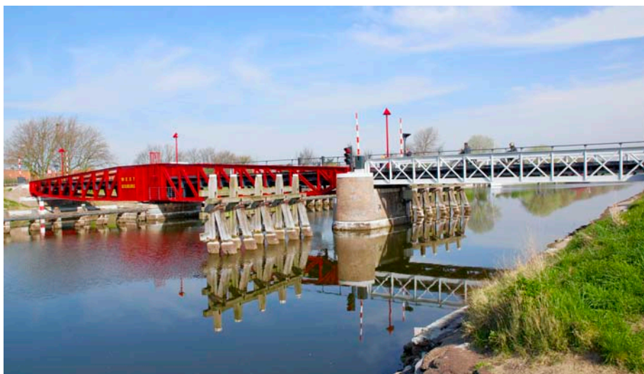
Een brug voor fietsers en voetgangers over het Kanaal door Walcheren tussen Oost- en West-Souburg in Zeeland.
