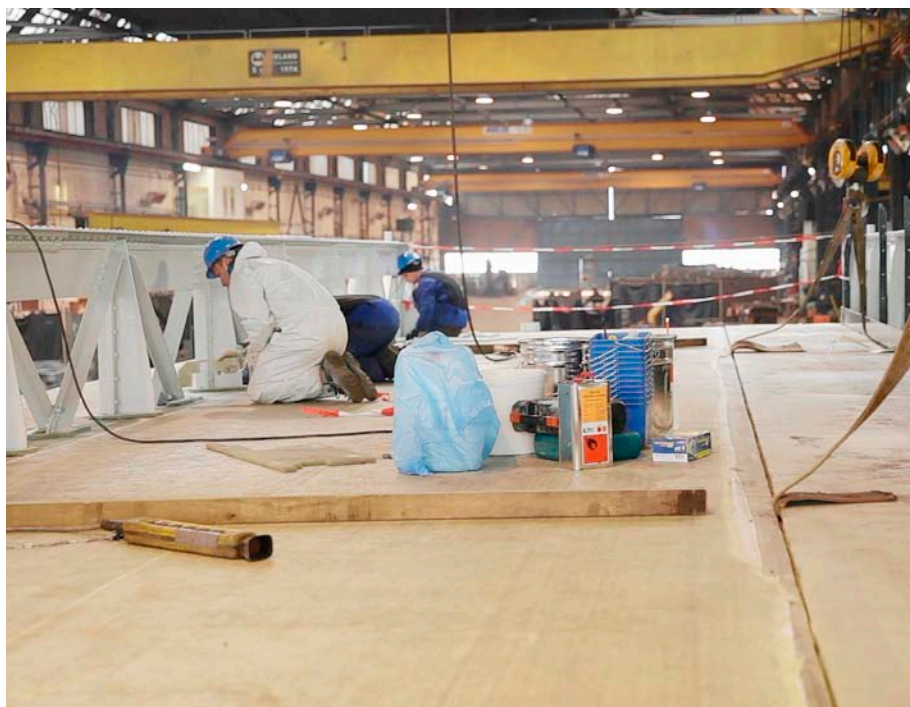
De grootste uitdaging in het project was de bevestiging van het composiet brugdek op de staalconstructie in de werkplaats van Hollandia Services.
