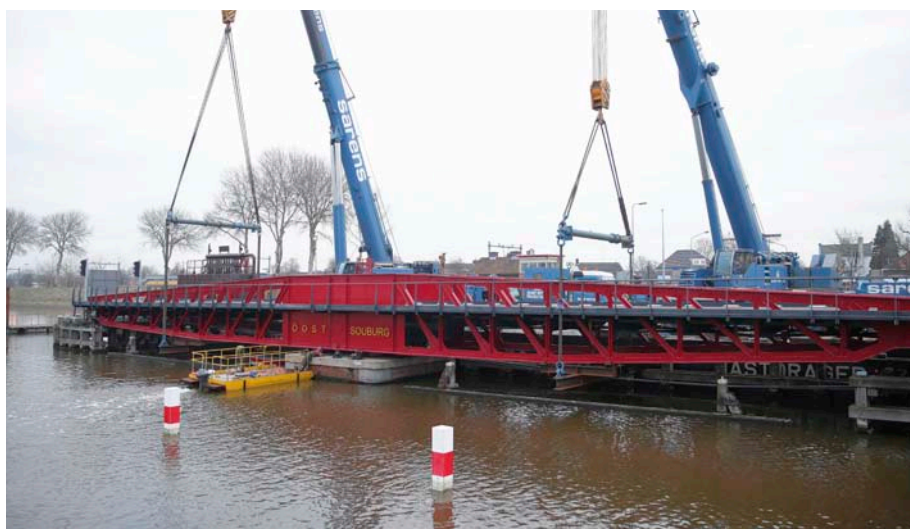
In februari van dit jaar is de vernieuwde brug ingehesen. De betrokken partijen verwachten dat de constructie lang mee kan.
