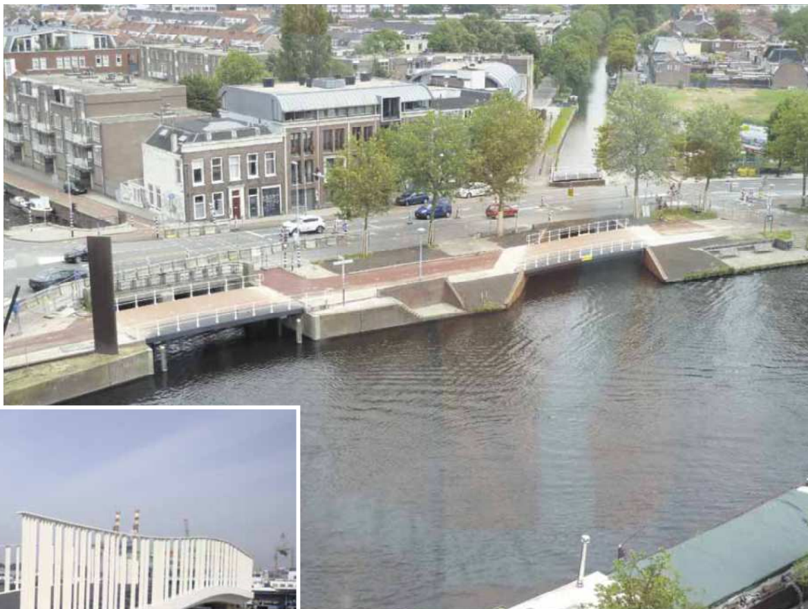
Twee InfraCore lichtverkeersbruggen voor de gemeente Haarlem met in het dek geïntegreerde hoofdgasleidingen en stoepen.
