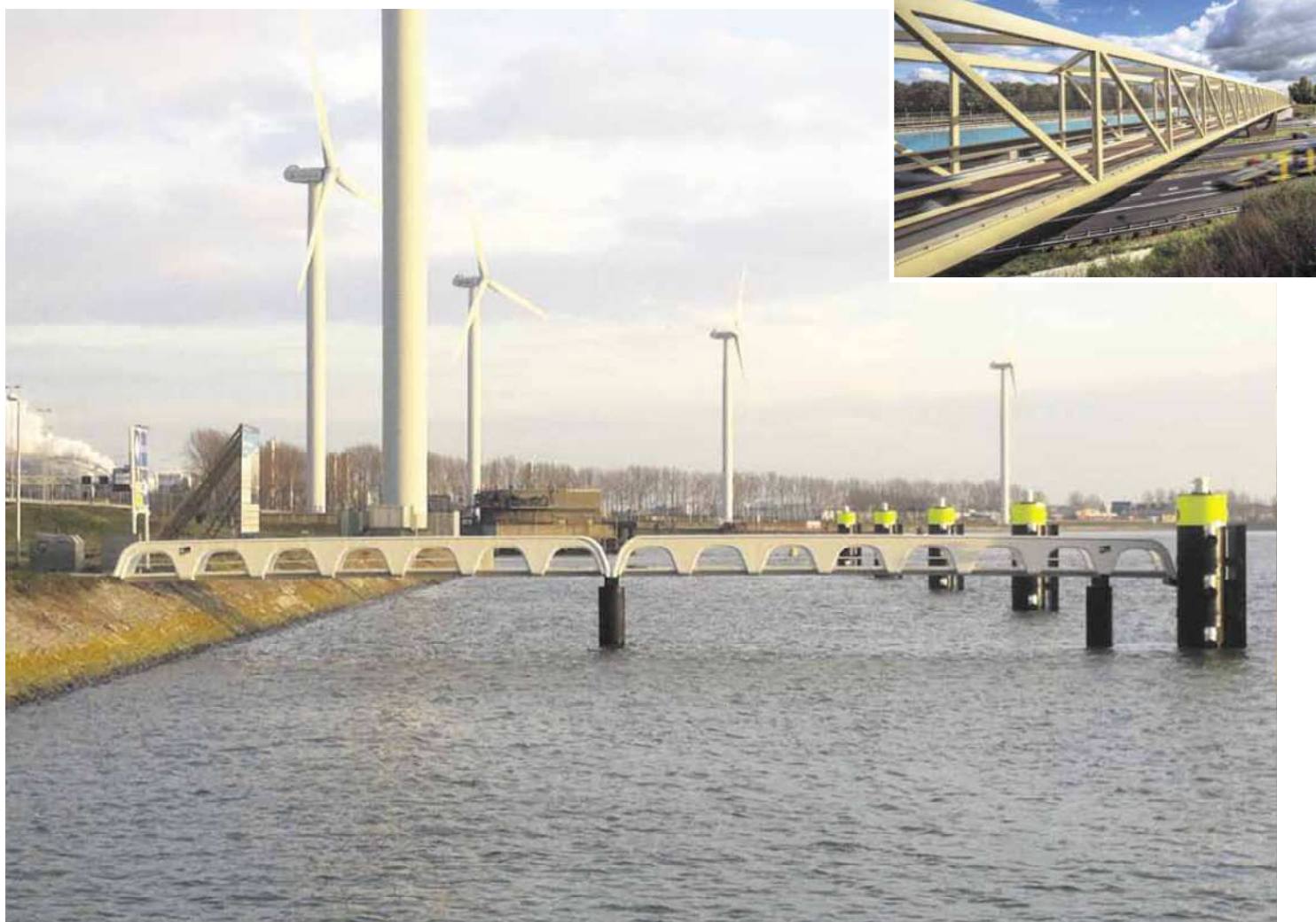
Volledige composietbrug in samenwerking met Havenbedrijf Rotterdam geplaatst in het Hartelkanaal in Europoort.
