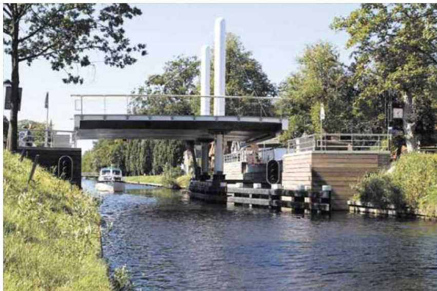
Foto Brug Foto Maarten: 's Werelds eerste composiet Eurocode hefbrug in Oosterwolde in opdracht van de Provincie Friesland.
