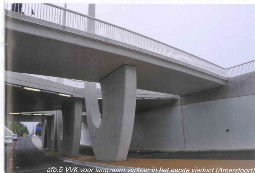
afb.5 VVK voor langzaam verkeer in het eerste viaduct (Amersfoort)
