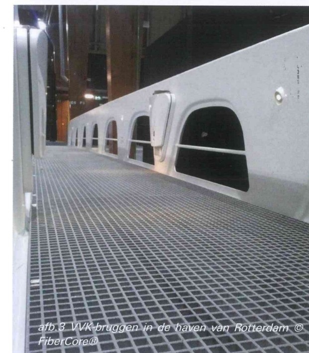
afb.2 VVK-bruggen in de haven van Rotterdam © FiberCore®
