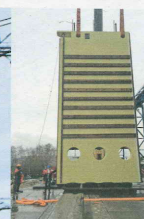
De composiet sluisdeur wordt bij FiberCore op een ponton getakeld voor transport naar Tilburg. Grote foto: Jan de Groen
