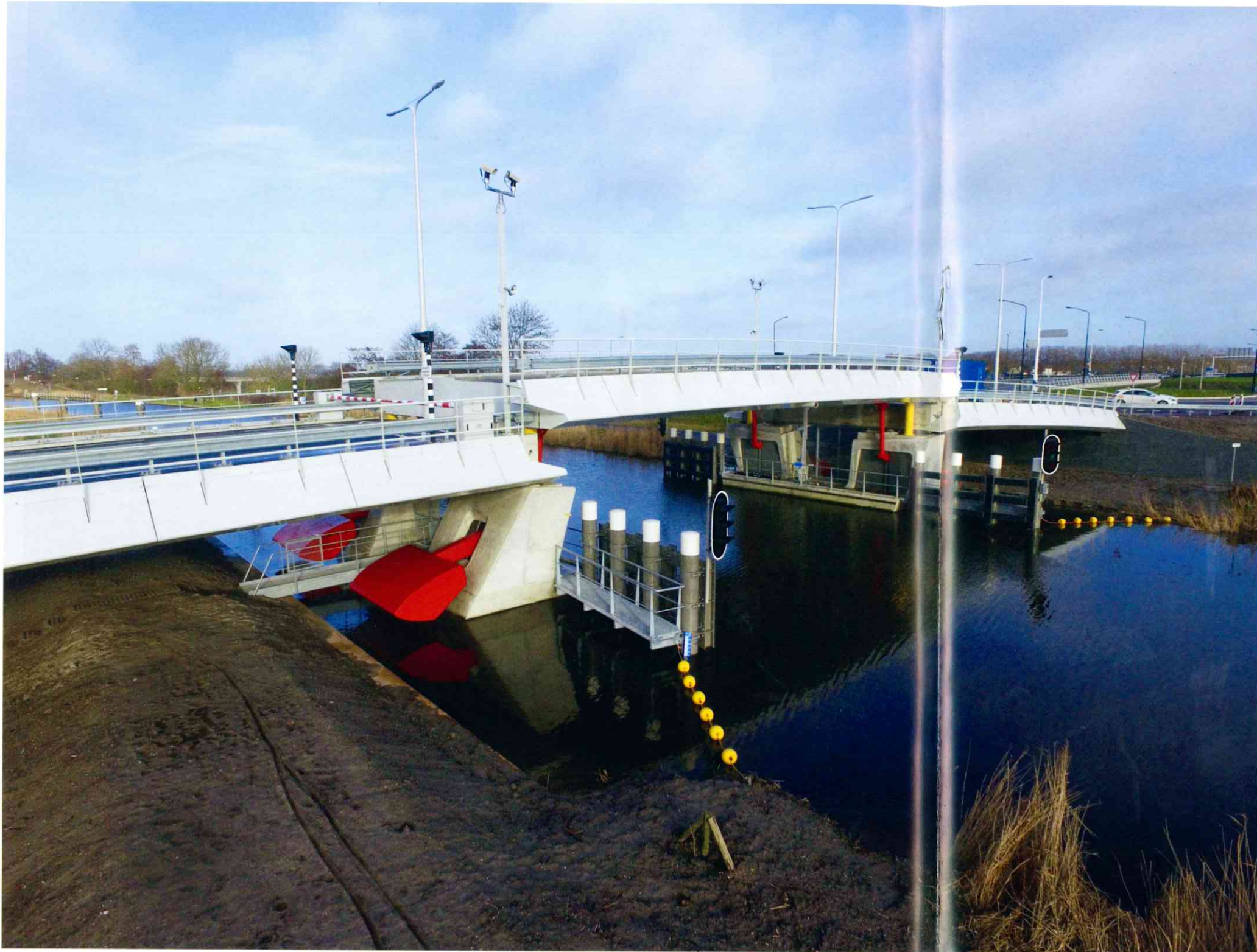
9 Nelson Mandelabrug, Alkmaar; tafelbrug (hefbrug met geringe hefhoogte – hier ongeveer 1,5 m) producent VVK: Delft Infra Composites
