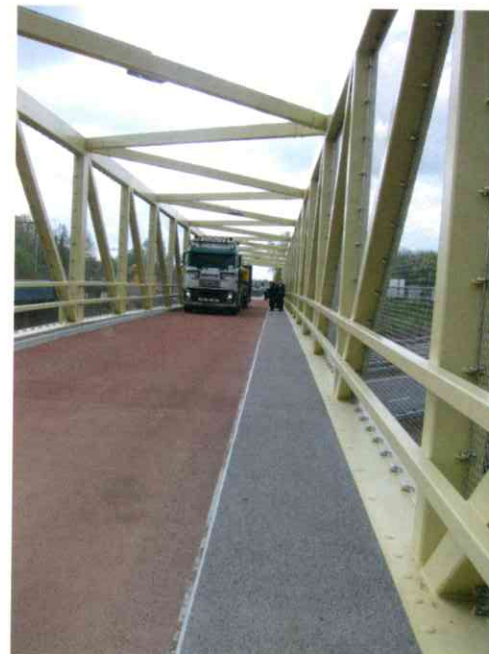
3 Hybride brug Lunetten voor voetgangers en autoverkeer 140 m lang en 6,2 m breed producent FiberCore Europe
