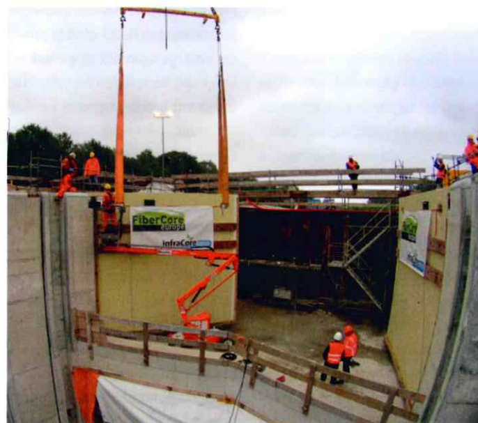
De grootste composiet sluisdeuren ter wereld: 13 x 6,20 meter.
