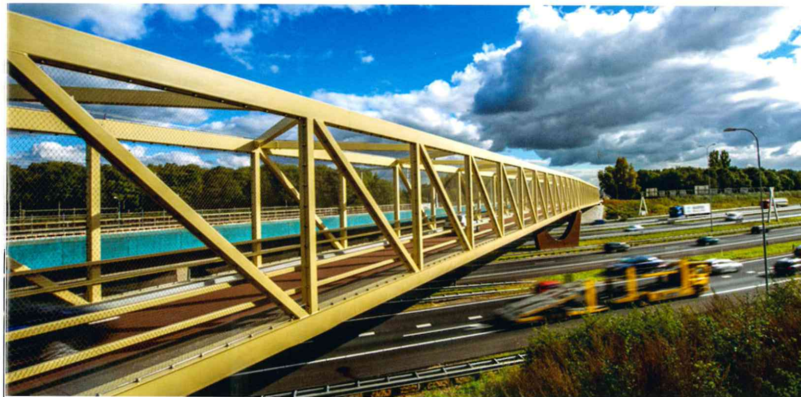
De 142 meter lange verkeersbrug over de A27 bij Lunetten. Een robuuste constructie die meer dan honderd jaar meegaat.
