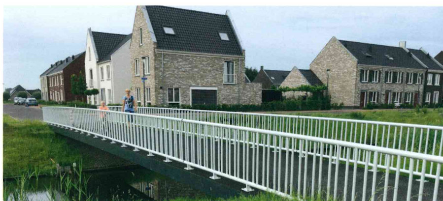
In Hattem is een ingeklemde brug met een lengte van 24 m en een constructiehoogte van 32 cm gerealiseerd.
