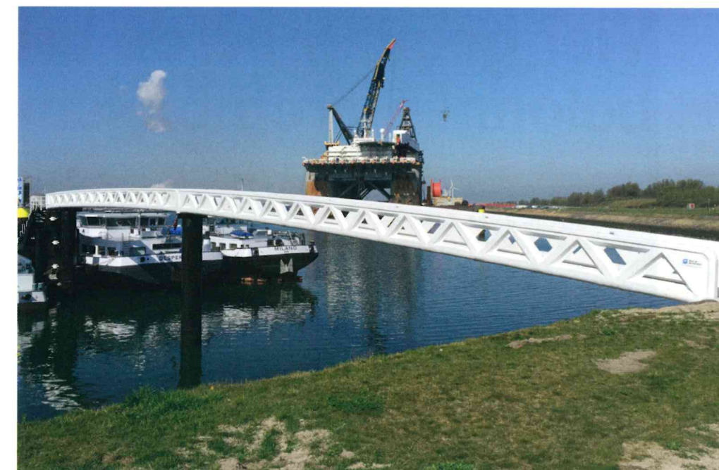
De Havenbruggen van FiberCore Europe zijn 100 procent in composiet uitgevoerd.
