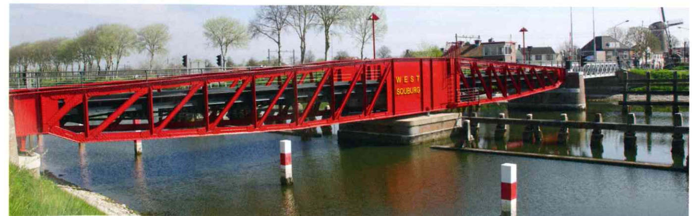
Het totaalgewicht van de gerenoveerde draaibrug (met een composietbrugdek) in Souburg is significant lager dan de oorspronkelijke uitvoering; aanzienlijk kortere openingstijden van de brug zijn het gevolg. In combinatie met het geringe onderhoud levert dit forse besparingen op.
