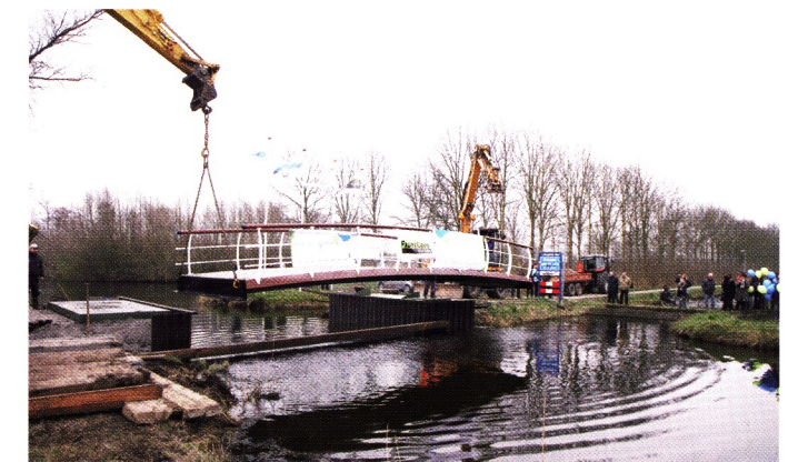
Twee lichte kranen zijn voldoende om de brug te plaatsen.
