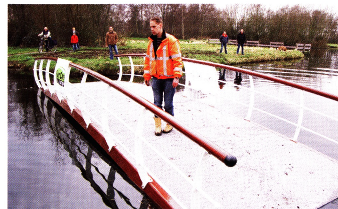
De brug is varend in positie gebracht.
