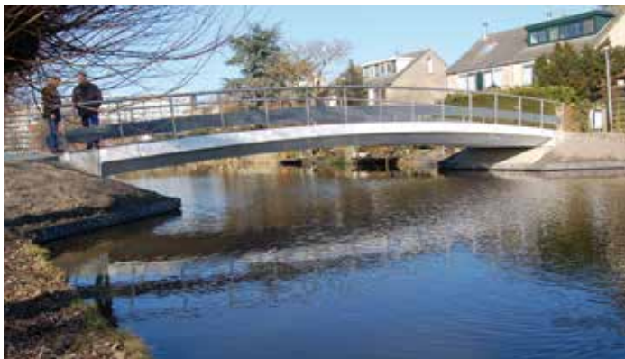
InfraCore® Inside fiets-/voetgangersbrug Purmerend.
