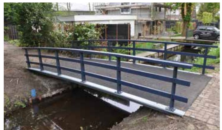
Deze InfraCore® Inside voetgangersbrug in Gent (Belgium) is zo licht dat deze eenvoudig aan de historische gebouwen kan worden bevestigd.
