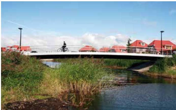
InfraCore® Inside fiets-/voetgangersbrug Dronten met een overspanning van 26 meter.
