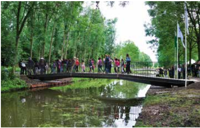
Eén van de 70 InfraCore® Inside bruggen in de gemeente Rotterdam.
