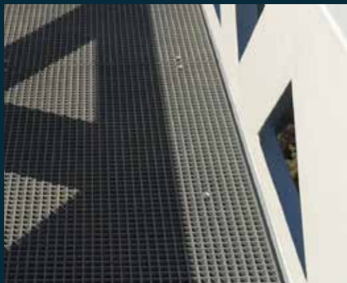
Onderhoudsvrije composiet roostervloer voorzien van slijtvaste slijtlaag.
