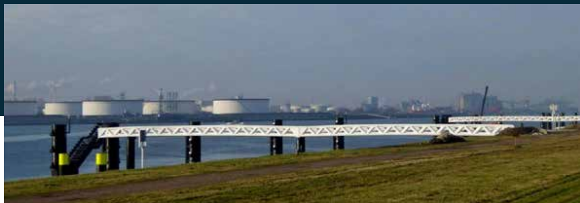
Eenvoudige gestandaardiseerde oplegging op paal, ponton, damwand.
