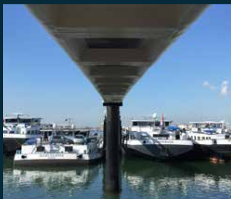
Eenvoudige gestandaardiseerde oplegging op paal, ponton, damwand.
