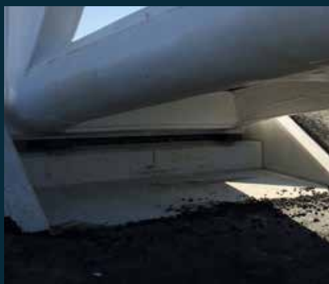
Eenvoudige gestandaardiseerde oplegging op paal, ponton, damwand.
