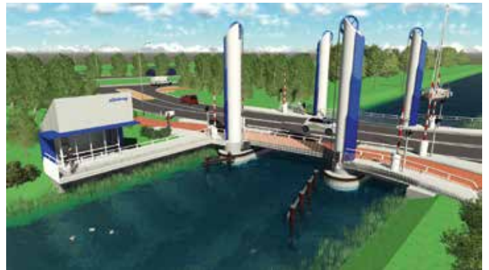
De hijskabels van deze hijsbrug zijn verbonden aan een stalen balk, welke is geïntegreerd in het InfraCore® Inside dek.
