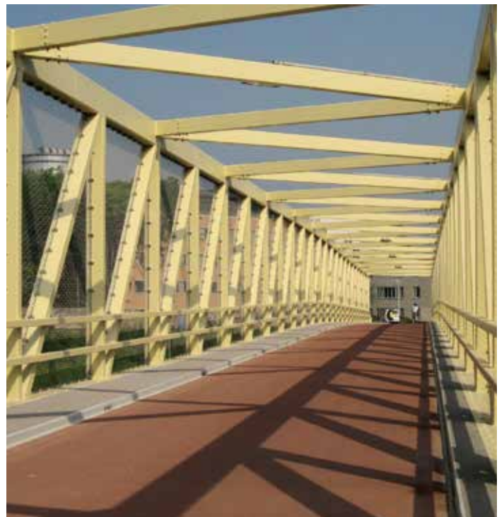
Brug over de A27.
