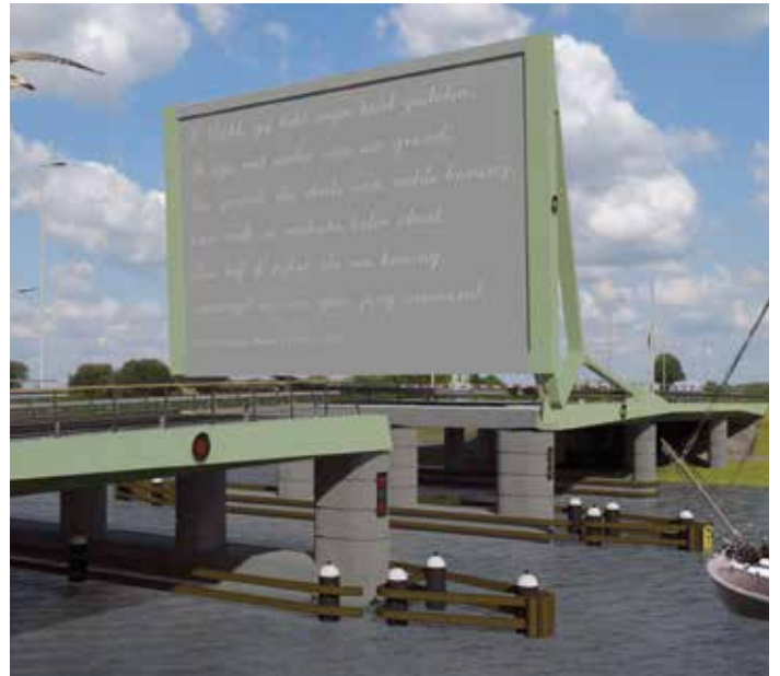
Hybride ophaalbrugmet InfraCore® Inside dek, passend binnen stalen balken van de mechanische installatie.
