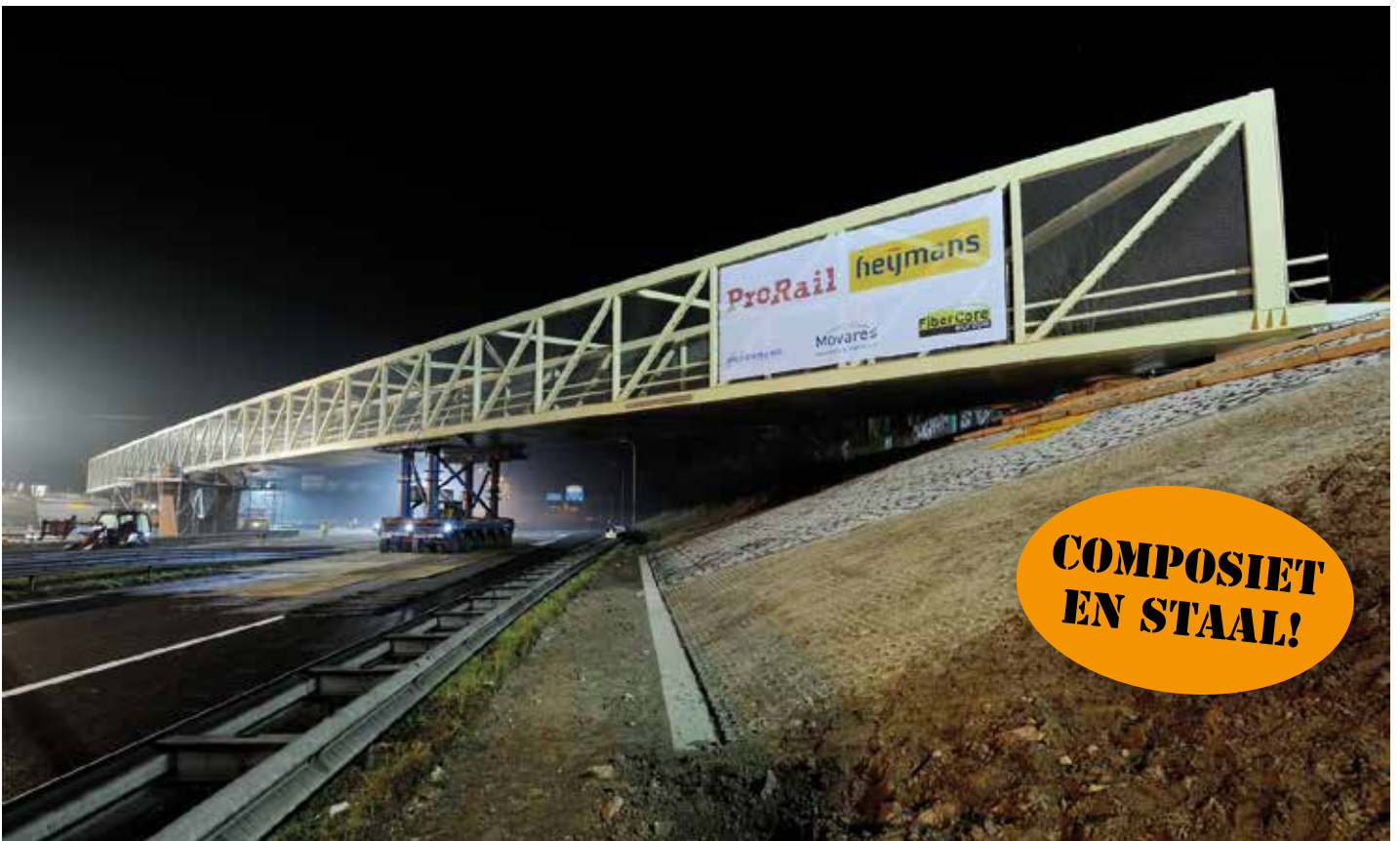
De installatie van een hybride brug over de A27 bij Lunetten.
