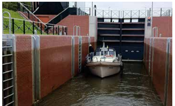
In de sluis van het kanaal Erica-Ter Apel.
