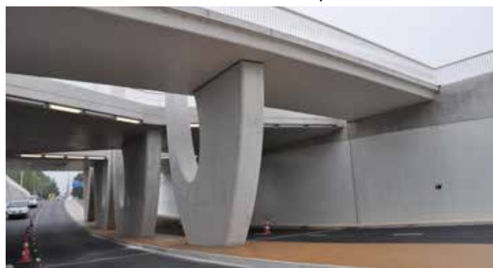
InfraCore® Inside verkeersbrug in Amersfoort, ondersteund door betonnen pilaren.
