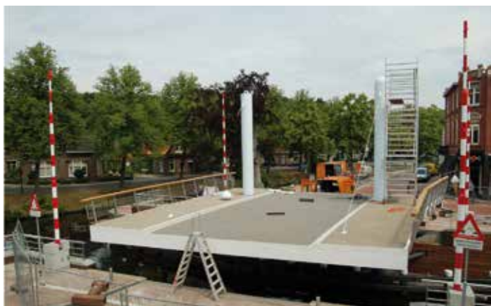
Brug in aanbouw in Oosterwolde. De pilonen verbergen het hydraulische hijsmechanisme.
