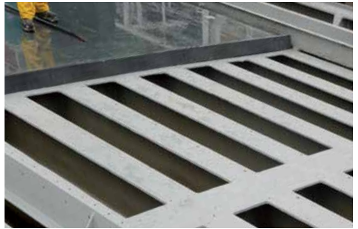
Stålkonstruktionen har renoverats och bevarats, och det första däcksegmentet i InfraCore® Inside har monterats.
