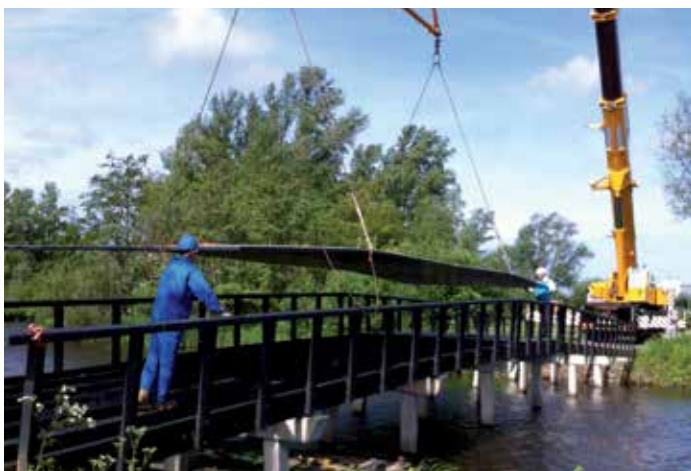
Montering av ett 15 × 4 m stort däck i InfraCore® Inside.
