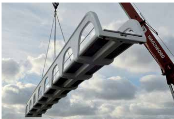
FiberCore Europes hamnbro är en lätt konstruktion som kan installeras på mindre än en timme.
