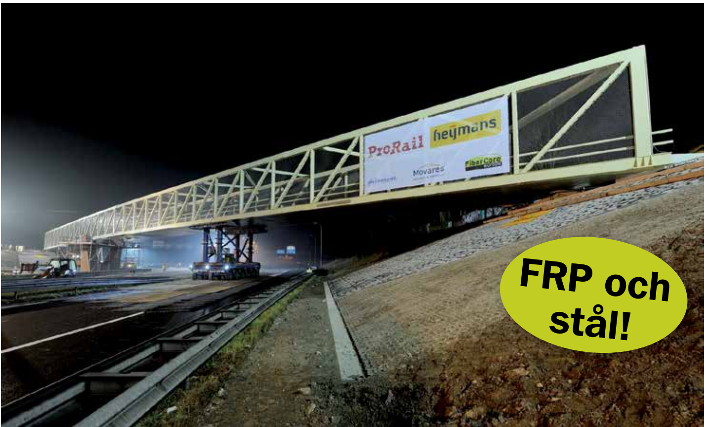
En hybridbro av FRP och stål halvvägs genom monteringen över motorvägen A27 nära nederländska Utrecht. Formgivning och konstruktion av brobanan i InfraCore ® Inside: FiberCore Europe.
