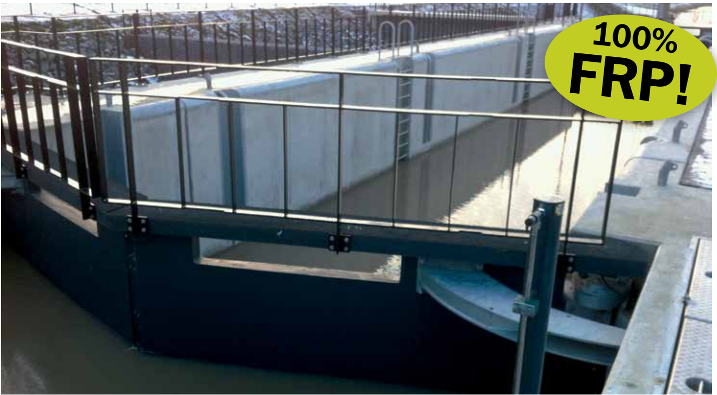
FRP-slussport av InfraCore ® Inside i kanalen Erica–Ter Apel.
