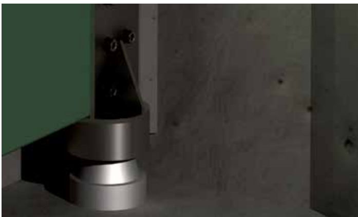
Slussportens nedre gångjärn.
