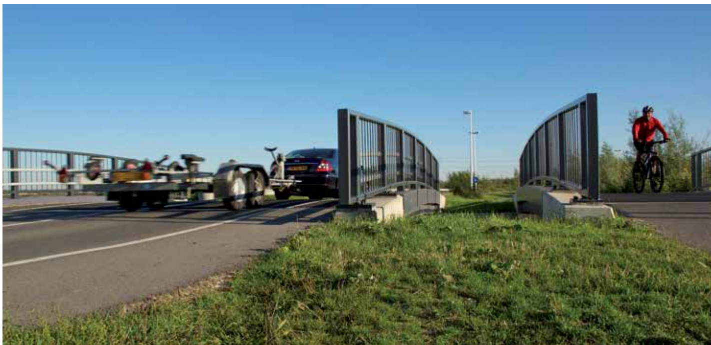
Vägbro nära Utrecht.
