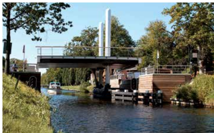
Höj- och sänkbar vägbro för fordon upp till 60 ton i Oosterwolde.
