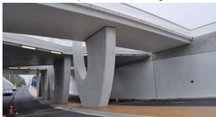
Vägbroar i InfraCore® Inside i nederländska Amersfoort. De vilar på en understruktur i betong.
