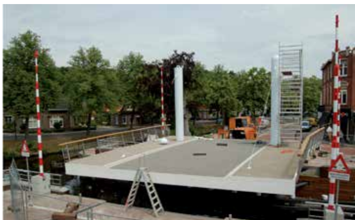
Bro under uppförande i nederländska Oosterwolde. Pylonerna skyddar den hydrauliska lyftmekanismen.
