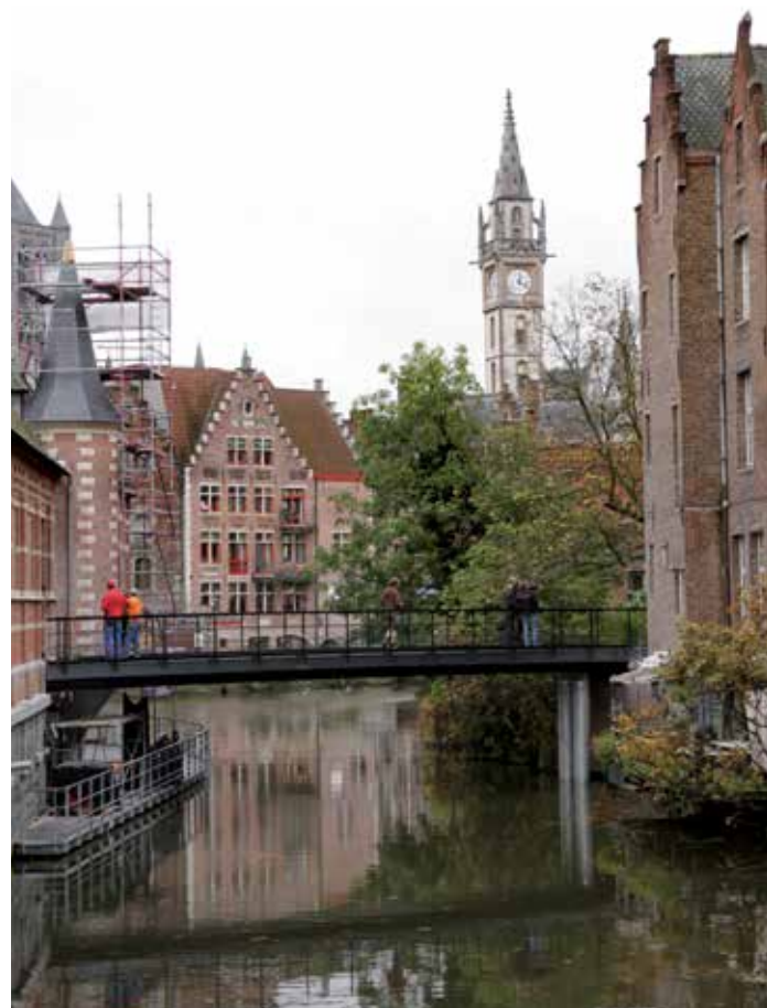
Den här gångbron i InfraCore® Inside i belgiska Gent är så lätt att den kan bäras upp av de historiska byggnaderna.
