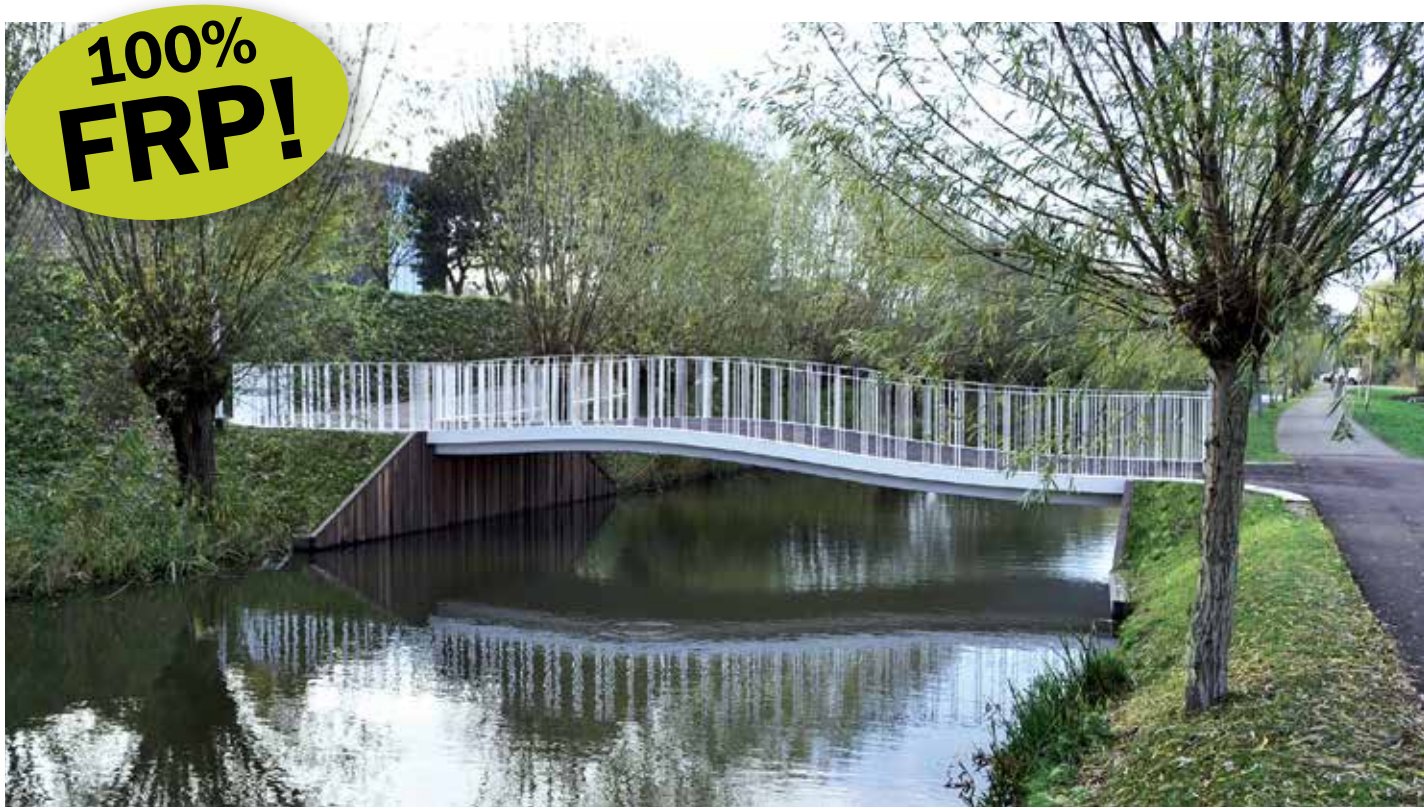
InfraCore ® Inside ger ett lågt underhållsbehov och lång konstruktionslivslängd, men också nya brokonstruktioner.
