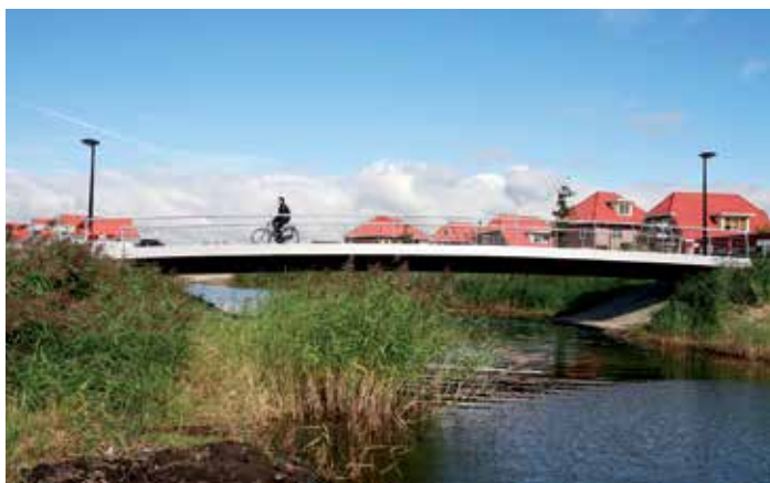
Gång- och cykelbro med en spännvidd på 26 meter i nederländska Dronten.
