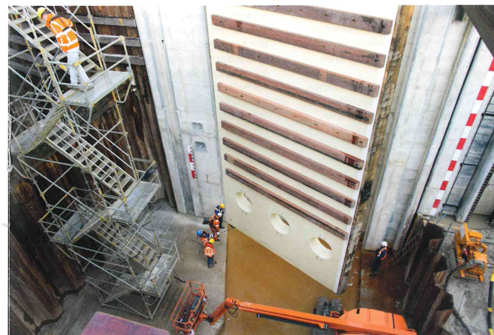
's Werelds grootste composiet sluisdeuren in Tilburg.
