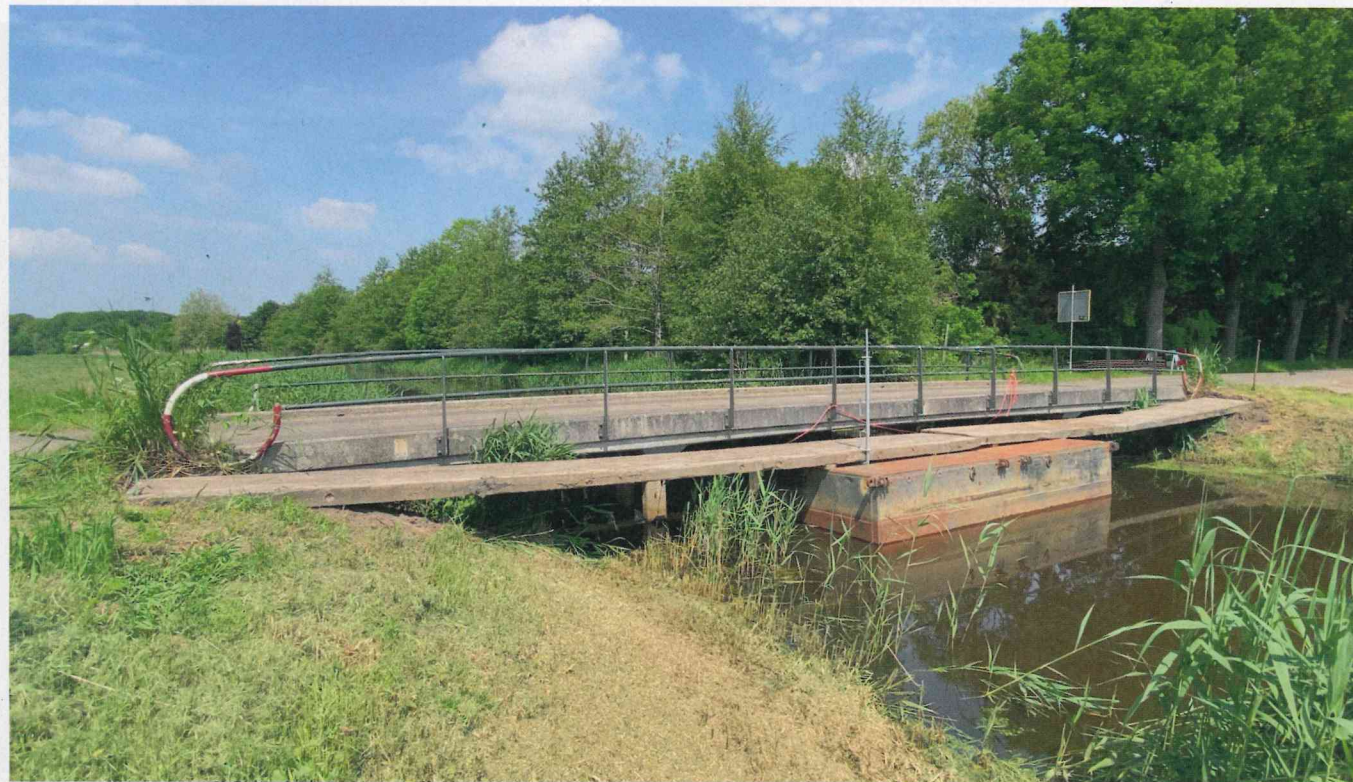
De brug in Hardenberg wordt straks voorzien van een 12 centimeter dik paneel van vezelversterkt kunststofcomposiet. Foto: FiberCore Europe
